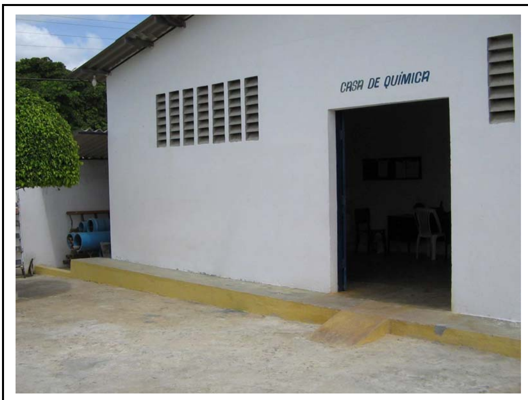
Foto 18 - Vista da fachada da casa de química.
