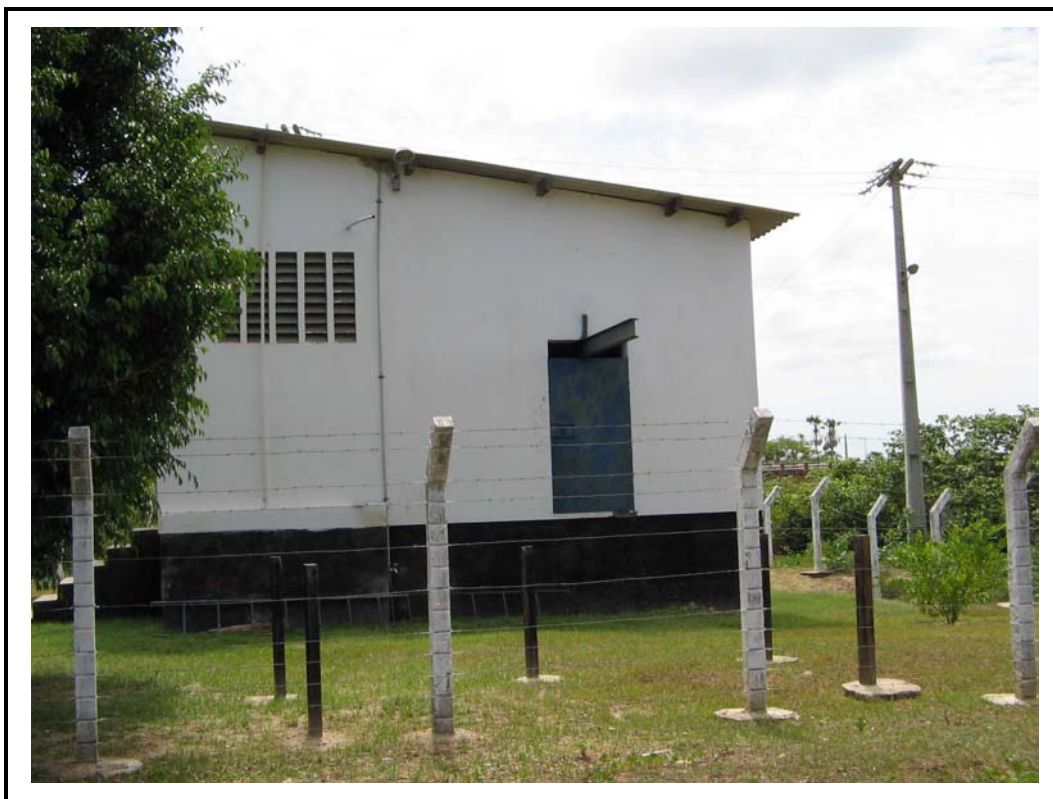
Foto 03 - Vista externa da casa de bombas da captação.
