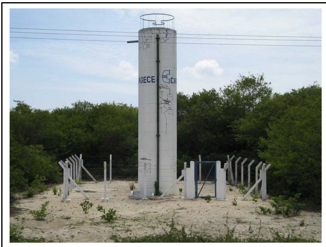
Foto 05 - Reservatório "one-way" localizado na estaca 187.
