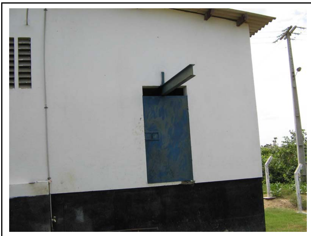
Foto 04 - Casa de bombas vendo-se extremidade da monovia.
