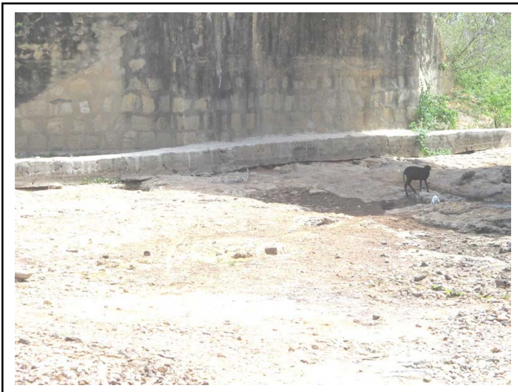
Foto 07 - Passagem da adutora sob ponte da rodovia CE-040.
