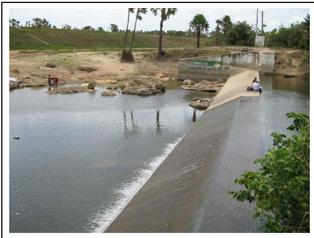
Foto 01 - Barragem vertedoura de elevação do nível da água.
