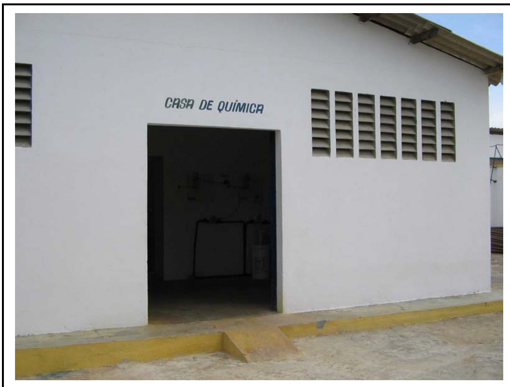
Foto 17 - Vista da fachada da casa de química.
