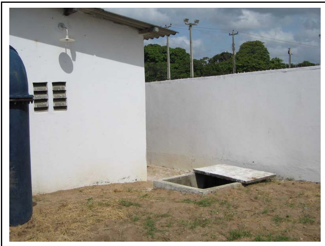
Foto 11 - Estação de bombeamento.
