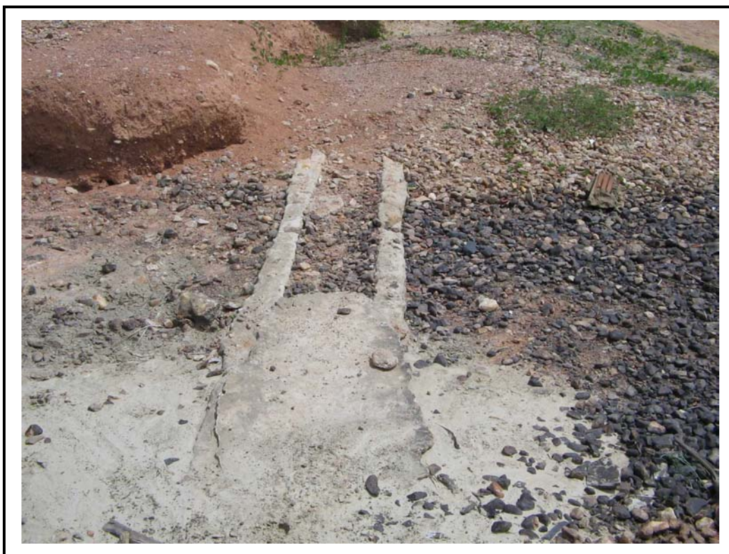
Foto 06 - Passagem da adutora sob leito do riacho.
